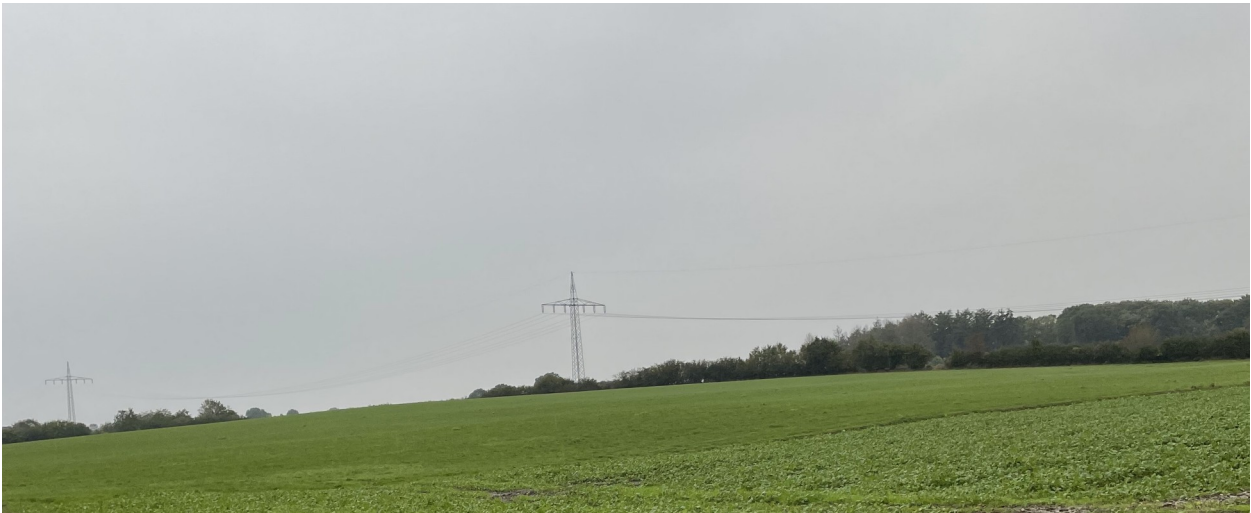
Abb. 8: Blick auf das Plangebiet
