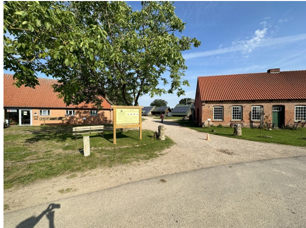
Abb. 25: Blick auf das Teile des Hofes Viehbrook von der begleitenden Straße (Fotostandort 11)
