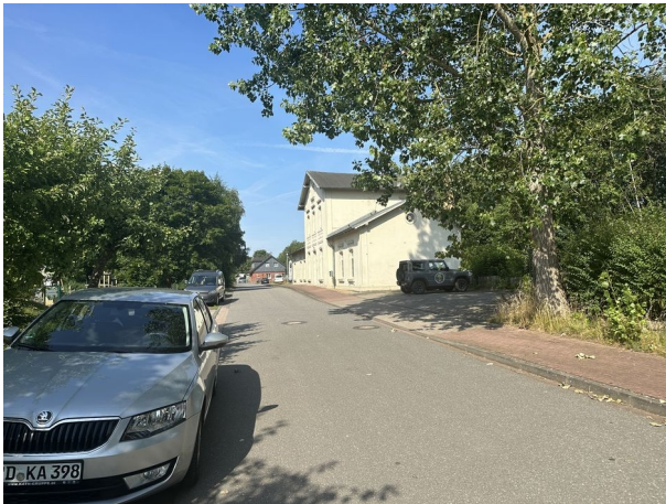
Abb. 28: Blick auf den Bahnhof in Wankendorf (Fotostandort 14)
