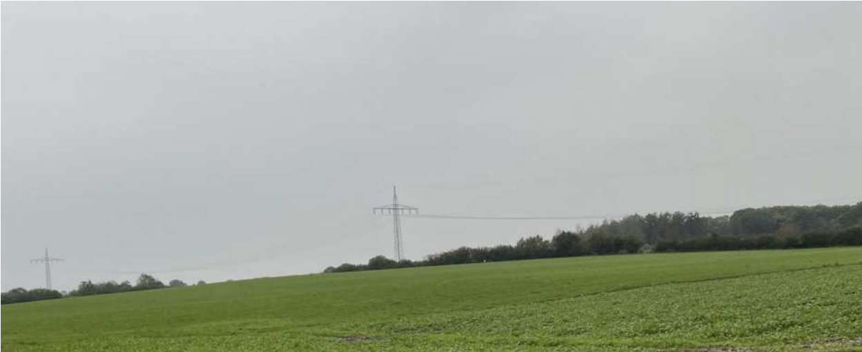
Abb. 8: Blick auf das Plangebiet
