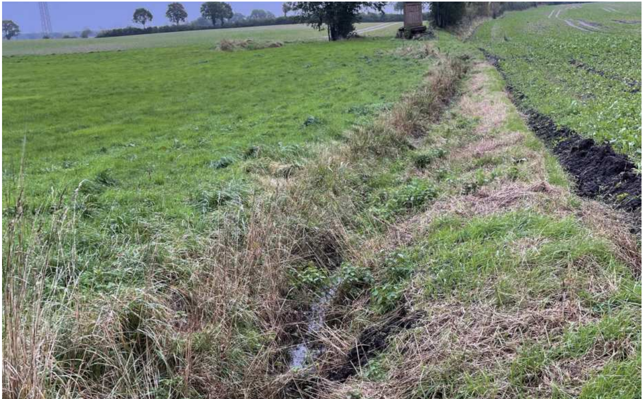
Abb. 11: Blick auf den Entwässerungsgraben
