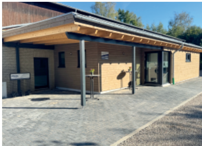
Die neuen Sanitär- und Sozial-Räume an der Wankendorfer-Tennishalle wurden eingeweiht
